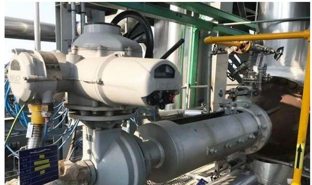
据悉，OCP 反应器系统工况设计温度高达 600℃，实际运行温度 550℃ 左右，由于工况对阀门密封的严格要求，所以对阀门的热应力计算、结构、材质及加工精度要求很高。安特威对该工况进行了非常深入的研究，并提供了相应的阀门解决方案，经国外工艺包厂商的严格测试，密封性和开关时间均优于行业标准要求，有效助力鲁西多元醇新材料有限公司 MTO 装置顺利开车。
