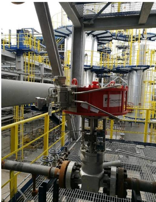
上图 4 PST 在某大型炼油厂 ESD 阀上的实际应用
